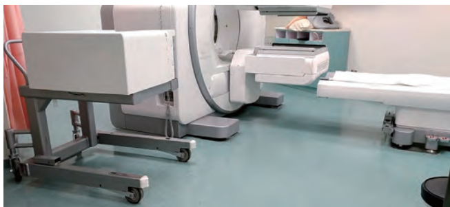
圖一：鋪設鋼板前之環境。
