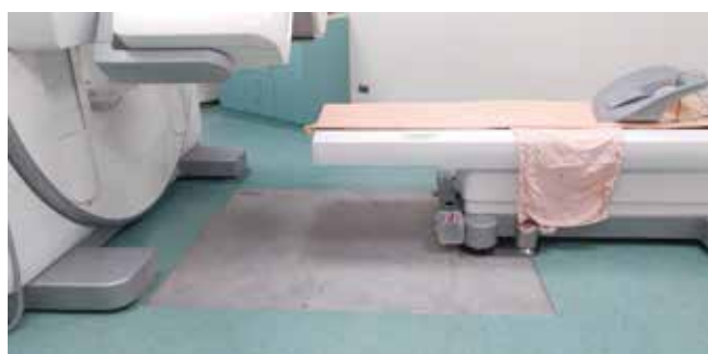
圖二：鋪設鋼板後
